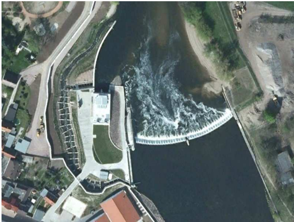
Abbildung 5.1: WKA Raguhn (Buchtenkraftwerk)
