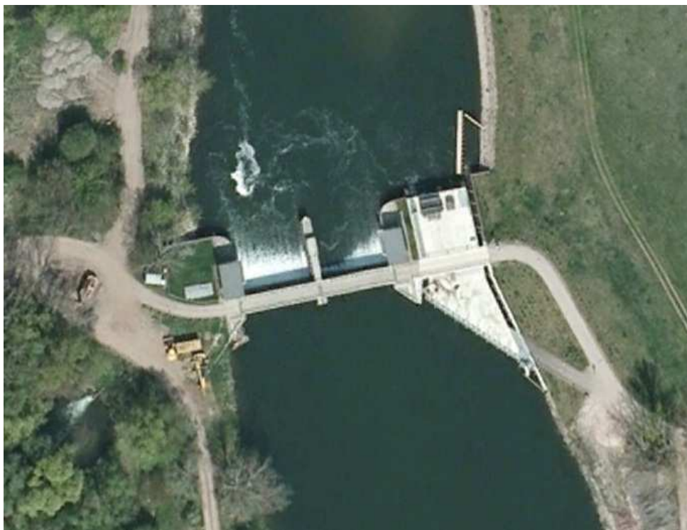
Abbildung 5.2: WKA Halle-Planena (Blockbauweise)
